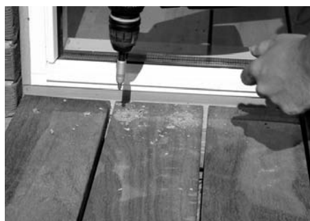
5. Der anvendes 5,0 x 50 mm rustfri skruer og planken forbores med 6 mm bor og forsænkes.
