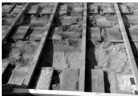
1. Opbygning af strøer på betonfliser - husk sokkelpap eller plastklodser.
