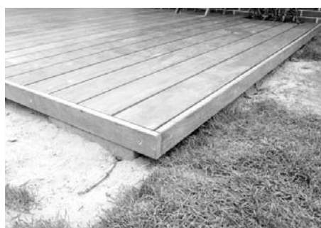
8. Bemærk at der er 15 mm afstand både mod siderne og enderne.
