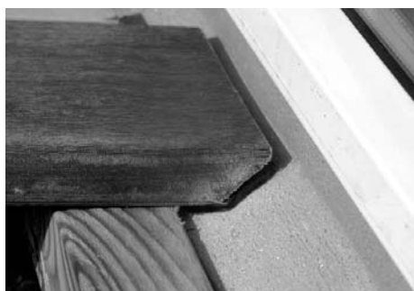
3. Plankerne lægges med 15 mm afstand til væg/kant.
