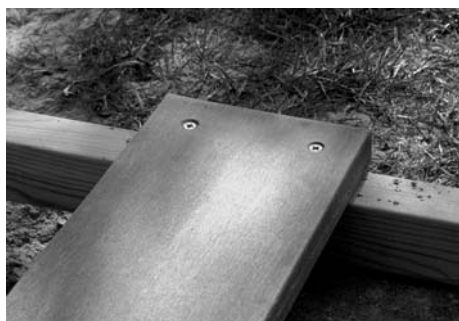
4. Plankerne fastgøres med 2 skruer pr. planke over hver strø. Der skal minimum være 25 mm fra plankens kant til skruehullets center.
